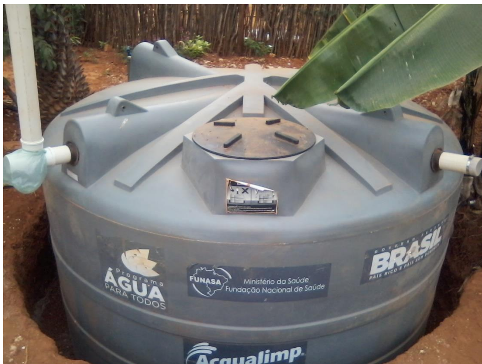
Figura 4-47 – Cisterna construída pela FUNASA em Almas.
