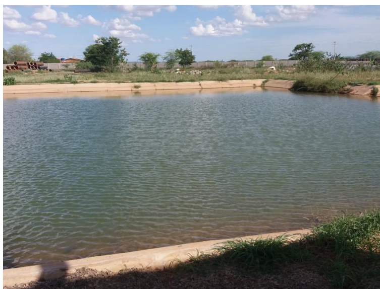
Figura 4-20 – Lagoa de descarga dos decantadores da ETA Rio Verde Fonte: Projeta Engenharia (2017)
