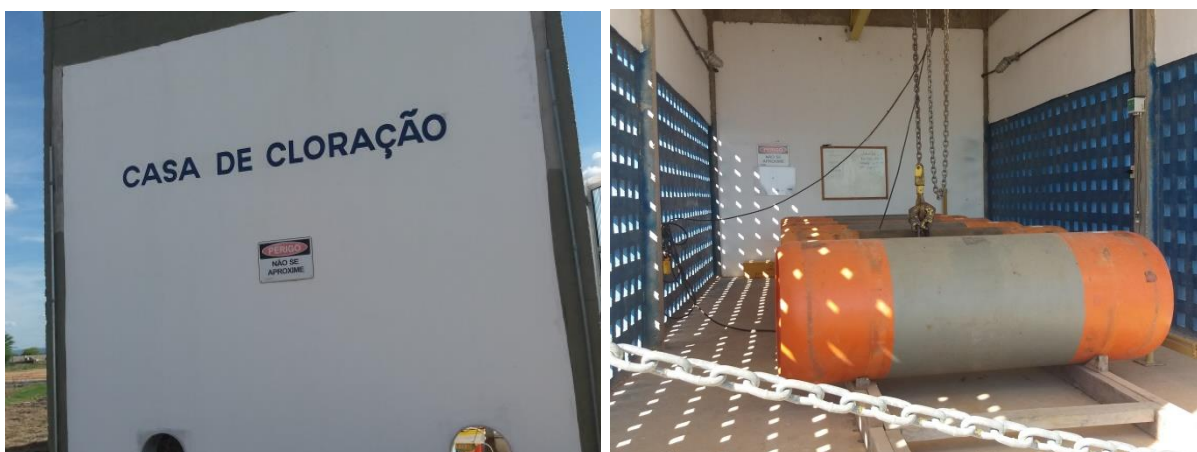
Figura 4-22 – Tinas de cloro destinado ao reservatório da Casa de Cloração da ETA Rio Verde
