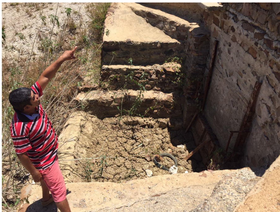
Figura 4-154 - Vista da comporta da barragem de Maravilhas
