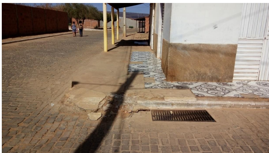
Figura 4-156 - Boca de lobo na rua José Peregrino de Souza
