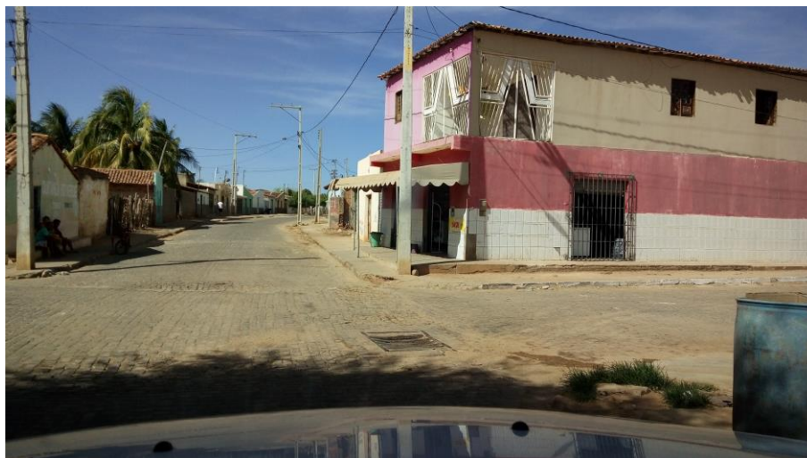
Figura 4-159 – Dispositivo de microdrenagem na localidade de Rio Verde II, próximo à rodovia BA-052.
