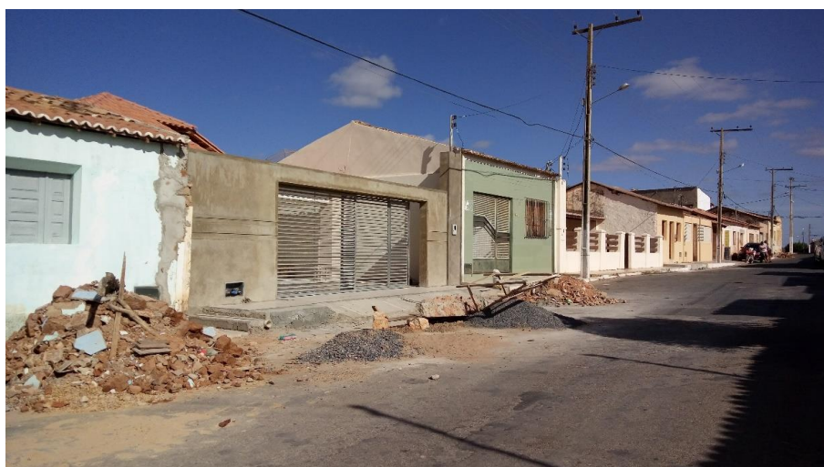
Figura 4-108 – RCC gerado em obras na sede de Itaguaçu da Bahia
