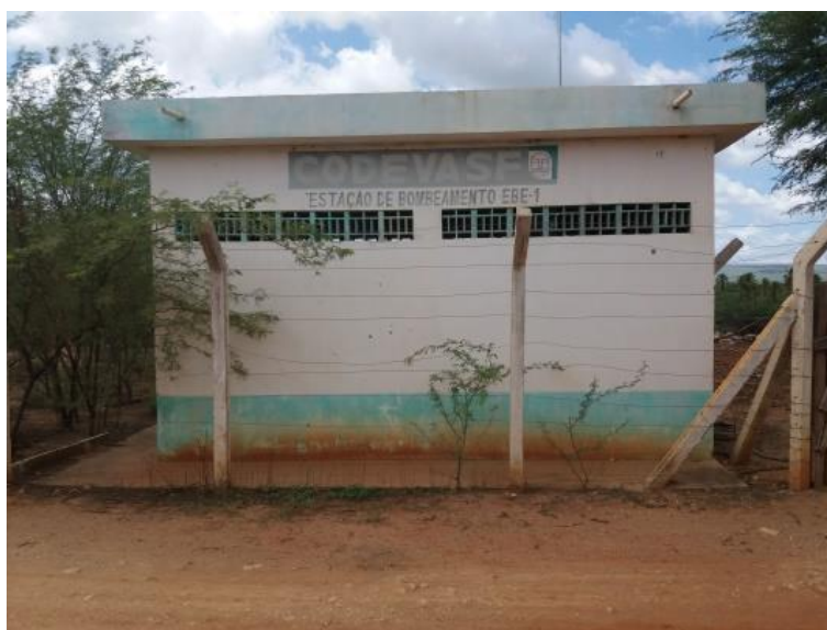
Figura 4-63 – Estação Elevatória EBE-1, na sede de Itaguaçu da Bahia.
