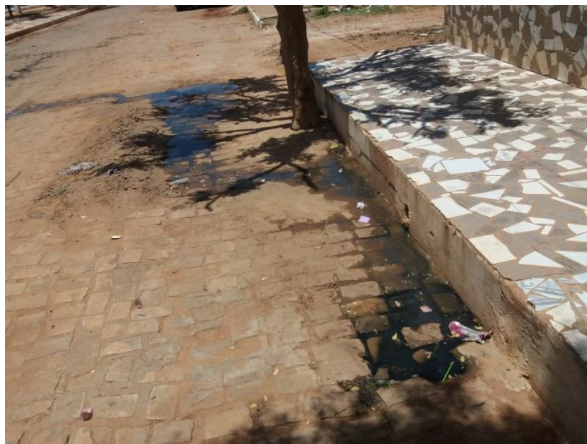
Figura 4-59 – Vazamento de esgoto na Rua Doutor Renan, na sede de Itaguaçu da Bahia.
