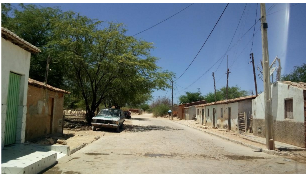
Figura 4-144 - Área sem dispositivos de microdrenagem no distrito de Rio Verde I
