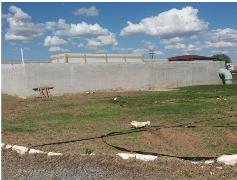
Figura 4-17 – Reservatório de água tratada para distribuição da ETA Rio Verde Fonte: Projeta Engenharia (2017)
