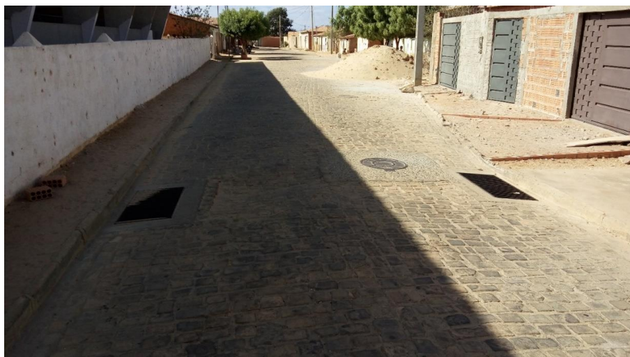
Figura 4-155 – Bocas de lobo situada na rua próximo ao ginásio
