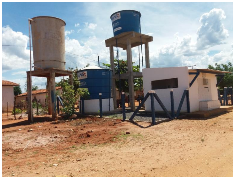
Figura 4-38 – Estação de Dessalinização em Bebedouro de Barreiros.
