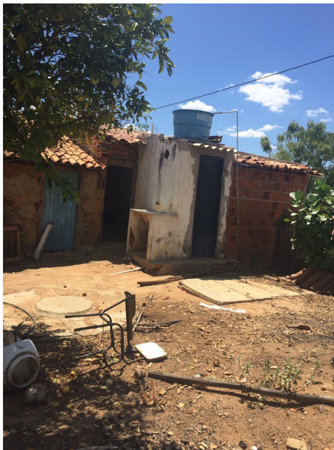
Figura 4-79 – Banheiro, tanque séptico e sumidouro instalados pela Funasa, em Maravilha.
