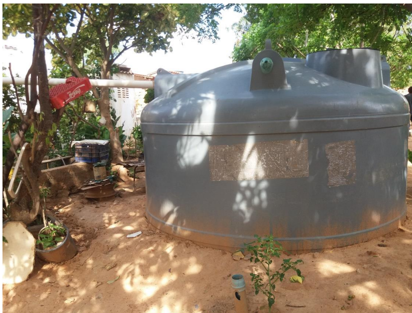
Figura 4-45 – Cisterna construída pela CODEVASF em Barreiros.
