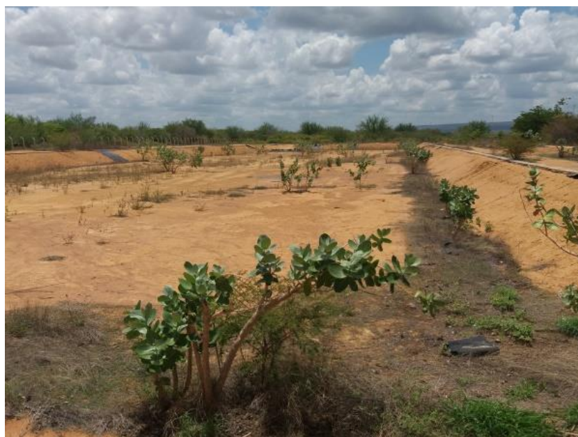
Figura 4-70 – Lagoa facultativa do SES, na sede de Itaguaçu da Bahia.
