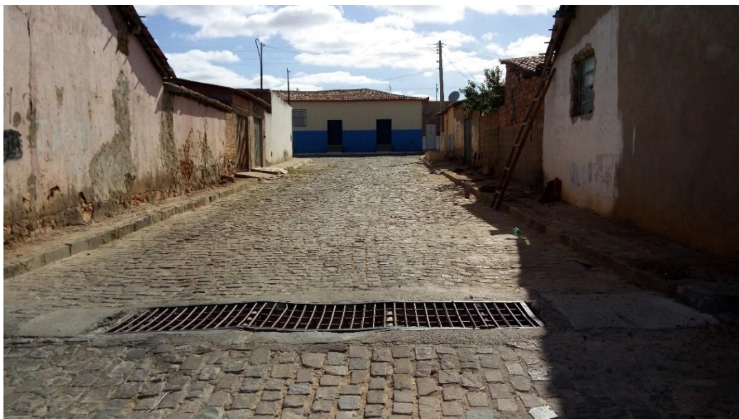
Figura 4-143 - Boca de lobo utilizada no controle da velocidade da água vinda da parte alta do Município
