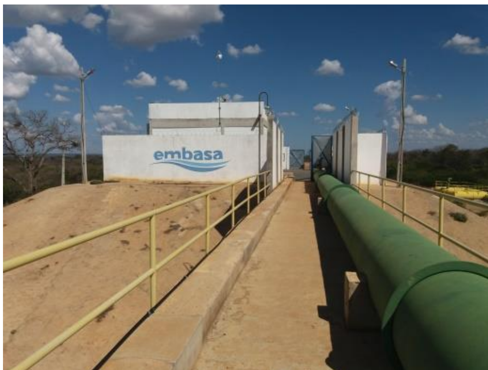
Figura 4-7 – Portões de entrada do local de captação e adutora de água bruta.
