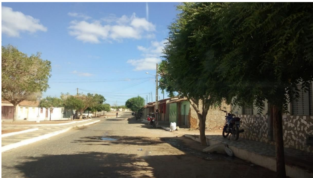
Figura 4-149 - Escoamento superficial de esgoto na Rua Renan Braga.
