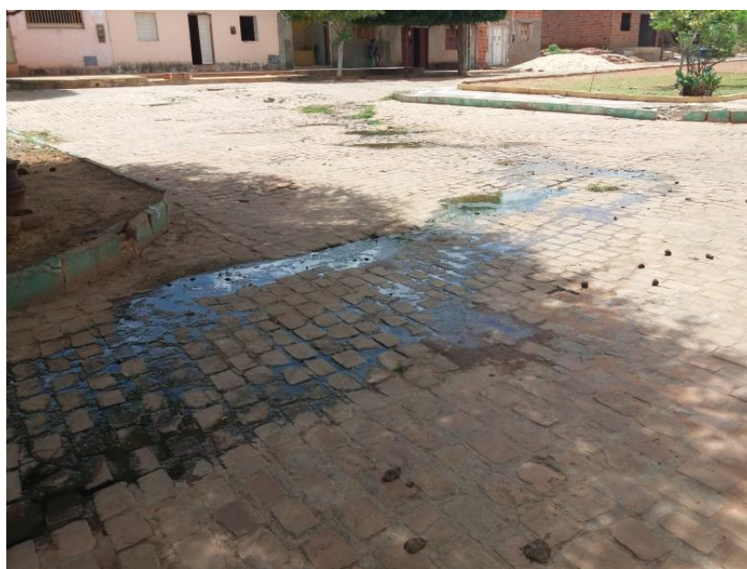
Figura 4-60 – Vazamento de água cinza na Rua Capitão Luizinho, na sede de Itaguaçu da Bahia.
