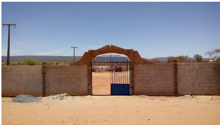
Figura 4-117 – Entrada do cemitério municipal da sede de Itaguaçu da Bahia
