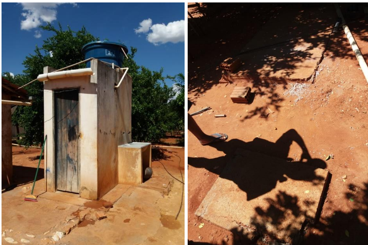
Figura 4-81 – Banheiro, fossa rudimentar e sumidouro instalados pelo Governo da Bahia e CAR, em Bebedouro de Barreiros.
