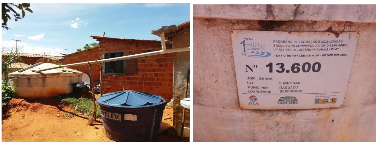
Figura 4-48 – Cisterna construída pelo P1MC e placa de identificação em Bebedouro de Barreiros.
