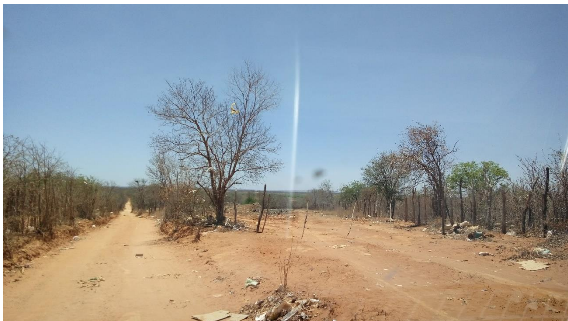
Figura 4-137 – Área de descarte irregular de RSD no Distrito de Barreiros Fonte: Projeta Engenharia (2017)
