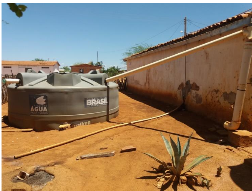
Figura 4-46 – Cisterna construída pela CODEVASF em Mundinho.
