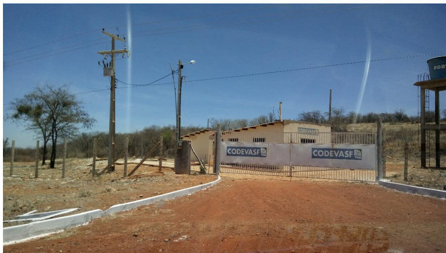
Figura 4-139 – Entrada principal do aterro sanitário no município de Irecê/BA
