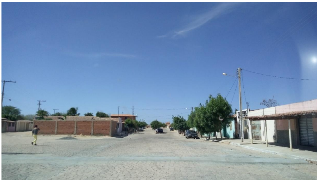
Figura 4-145 - Área sem dispositivos de microdrenagem no distrito de Mundinho
